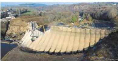
Décembre 2019 : les engins de démolition sont à l'œuvre et grignotent le béton des voiles à contrefort du barrage de Veziens. (Photo: ODM/Meow)
