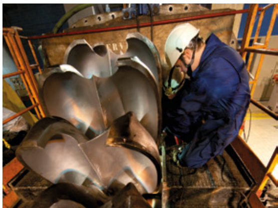
Maintenance sur une roue Pelton
