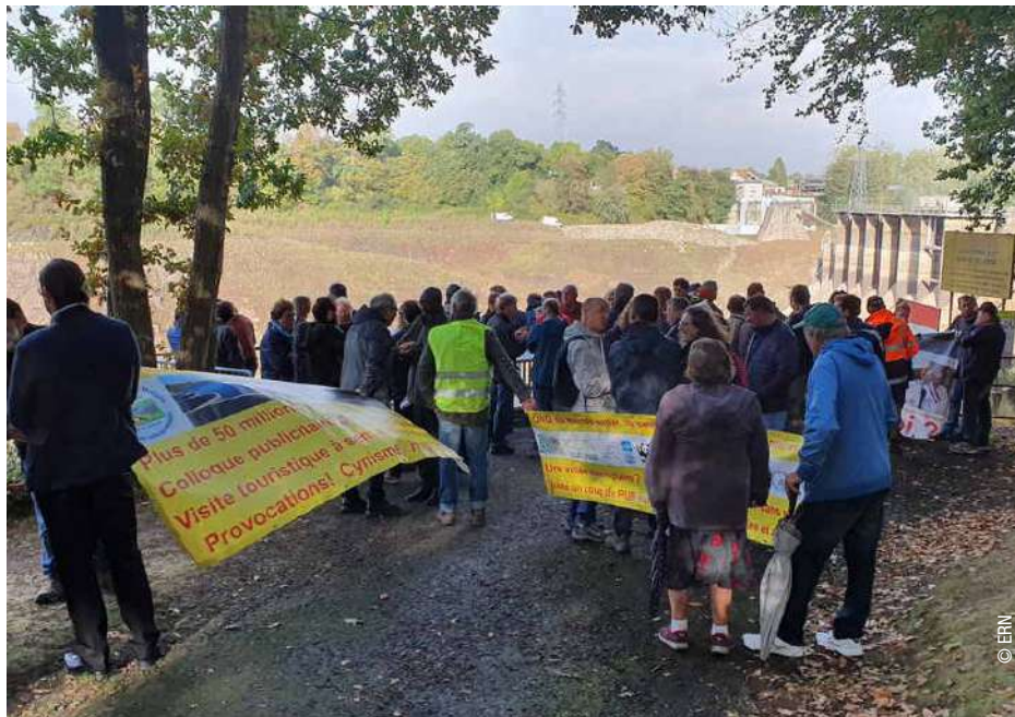
Visite du chantier d'effacement du barrage de Veziens (Manche) sur la Sélune le 26 Septembre 2019.
