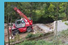
Chantier sur la Desges
