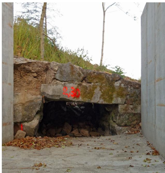
*Photo 3 : Pont juste en amont du dégrilleur, vu de l'aval le 26 octobre 2017. Le sol reconstruit du béal, en aval du pont, est environ 20 cm plus haut que le sol sous le pont. Le pont est large de 160 cm, tandis que le canal*
