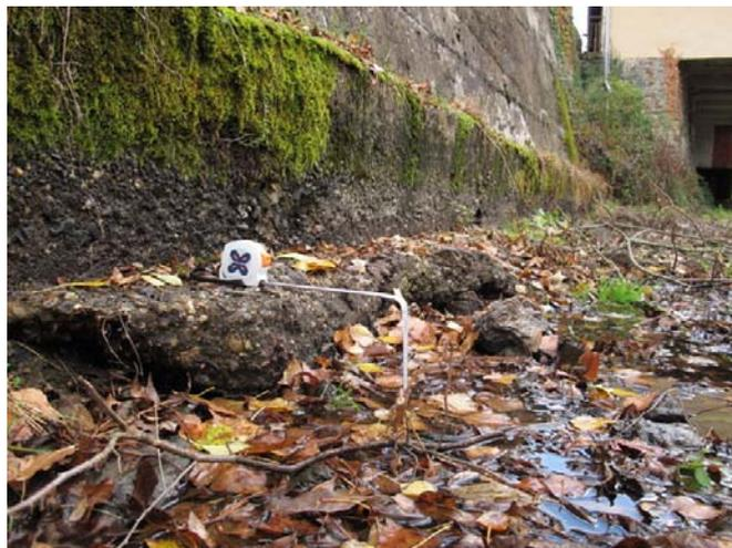
*Photo 4 : Creusement naturel du béal de 10 à 16 cm hors sol cimenté à proximité des parcelles AE 241 et 242.*
