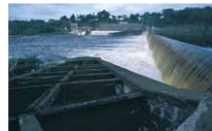
Barrage de Veazie
