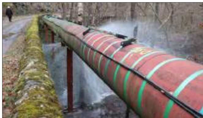
Photo 25 : Fuite sur la conduite forcée alimentant la microcentrale de Desges, ceinturée de sangles tous les 60 cm, et panneau de danger, le 23 janvier 2018.
