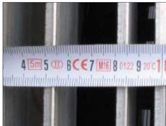
Photo 20 : Grille du dégrilleur : fers tordus par endroits (à gauche), d'où des espacements entre fers allant jusqu'à 26 mm au moins (à droite).
