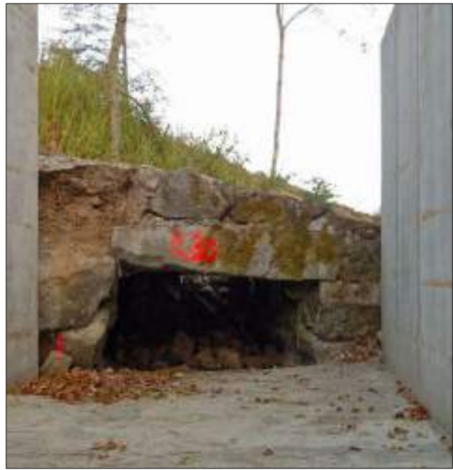
Photo 41 : Pont juste en amont du dégrilleur, à 488 m de la vanne d'entrée, vu de l'aval le 26 octobre 2017.
