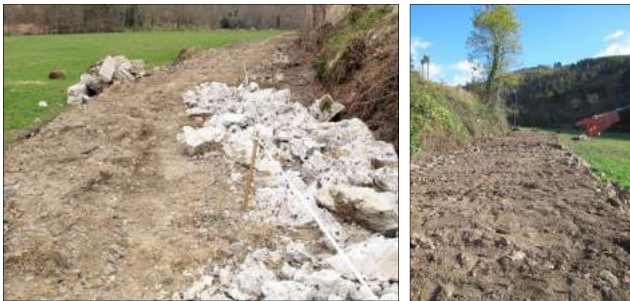
Photo 7 : État du béal aval après son arasement, avec à gauche indication de la limite de la parcelle du béal par un ruban blanc.
