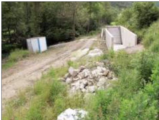
Photo 13 : Parcelle AE 226 après travaux, avec, à droite, le béal reconstruit puis le dégrilleur et, au fond au milieu, le déversoir (cliché pris le 8 juin 2018).
