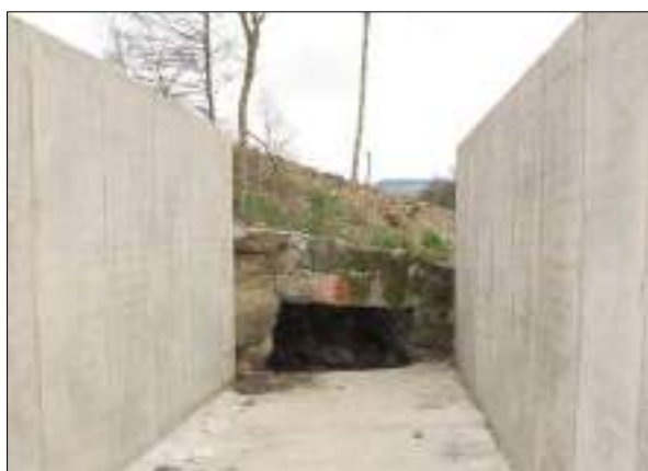
Photo 5 : Début du béal amont reconstruit entre le pont sur l'ancien béal et le dégrilleur.
