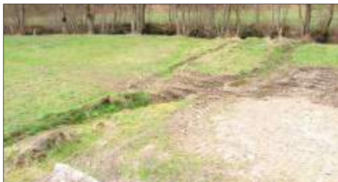
Photo 8 : Tranchées initiale (à gauche) et finale (reconfigurée, à droite).
