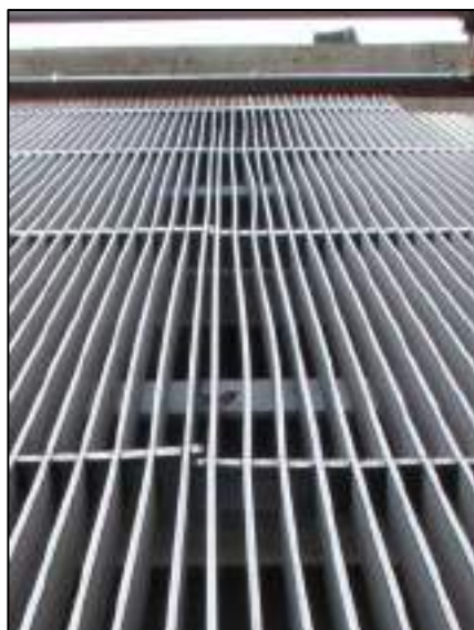
Photo 20 : Grille du dégrilleur : fers tordus par endroits (à gauche), d'où des espacements entre fers allant jusqu'à 26 mm au moins (à droite).
