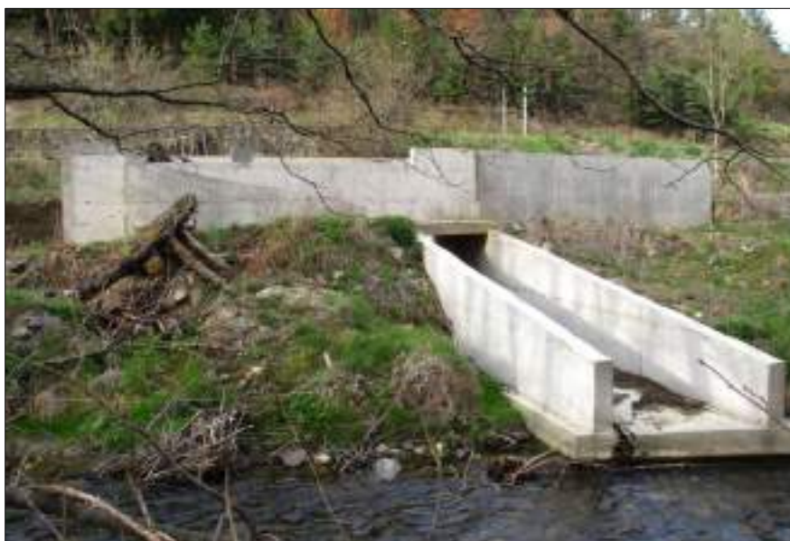
Photo 4 : Dégrilleur, début du béal amont rehaussé et déversoir terminés fin octobre 2017. Le pont sur l'ancien béal est à droite de la photo et immédiatement à droite du mur du béal rehaussé.
