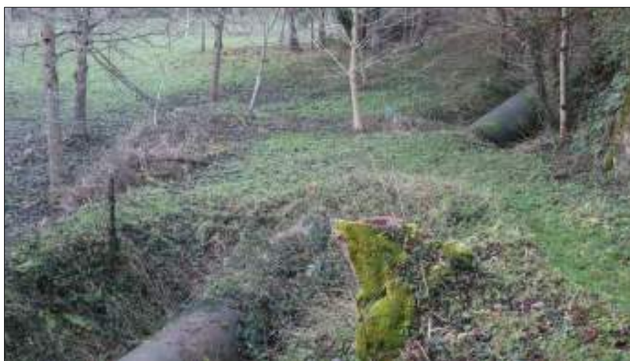
Photo 48 : Vue de la conduite forcée alimentant la microcentrale de Chazelles, le 23 janvier 2018.
