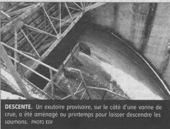
**DESCENTE.** Un exutoire provisoire, sur le côté d'une vanne de crue, a été aménagé au printemps pour laisser descendre les saumons. PHOTO EDF
